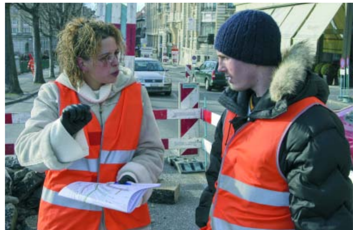
Du bureau au chantier, de la planification aux explications sur le terrain, l'ingénieure Emmanuelle Rohrbasser planifie et coordonne les travaux à effectuer sur un bout de route du centre ville lausannois.
